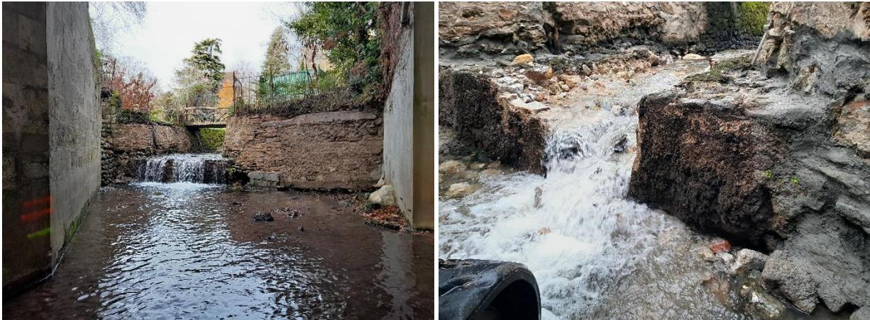
Vue des travaux préparatoires et de l'arasement du seuil de la Bourdonnerie à l'amont du radier du pont
