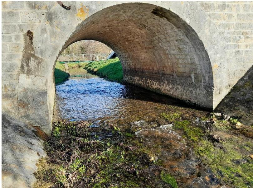
**Figure 7 – Radier de pont vu par l'aval**
