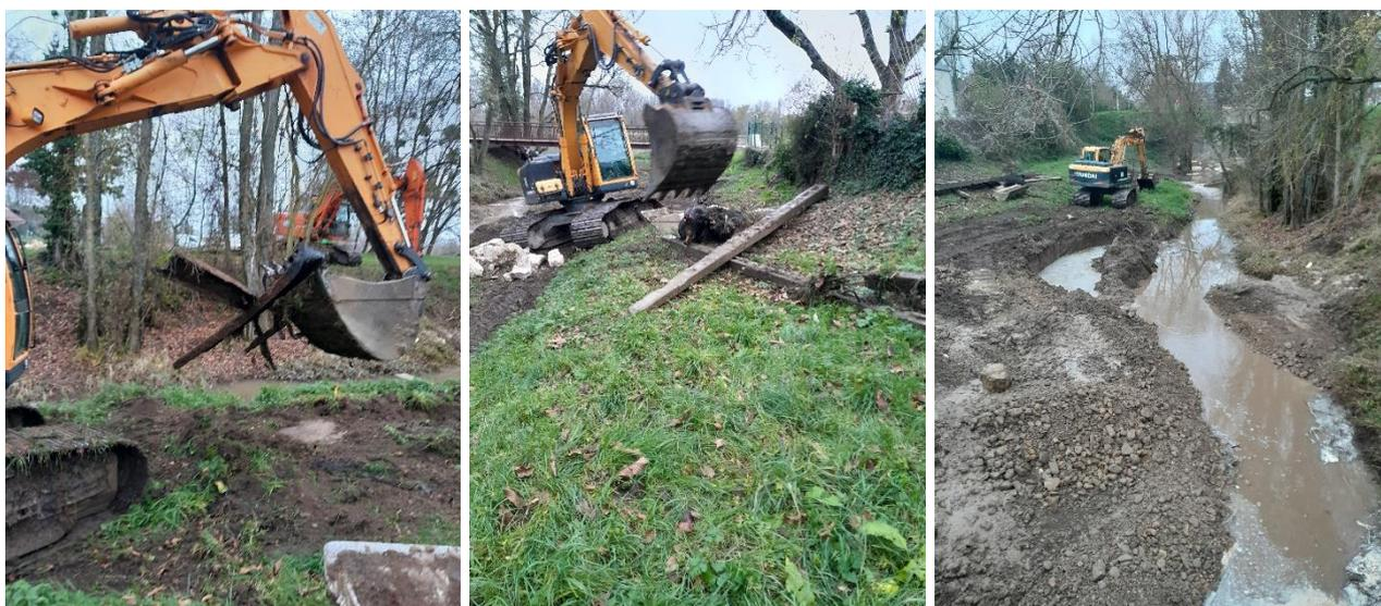
Retrait des matériaux artificiels au fur et à mesure des travaux de terrassement du nouveau lit
