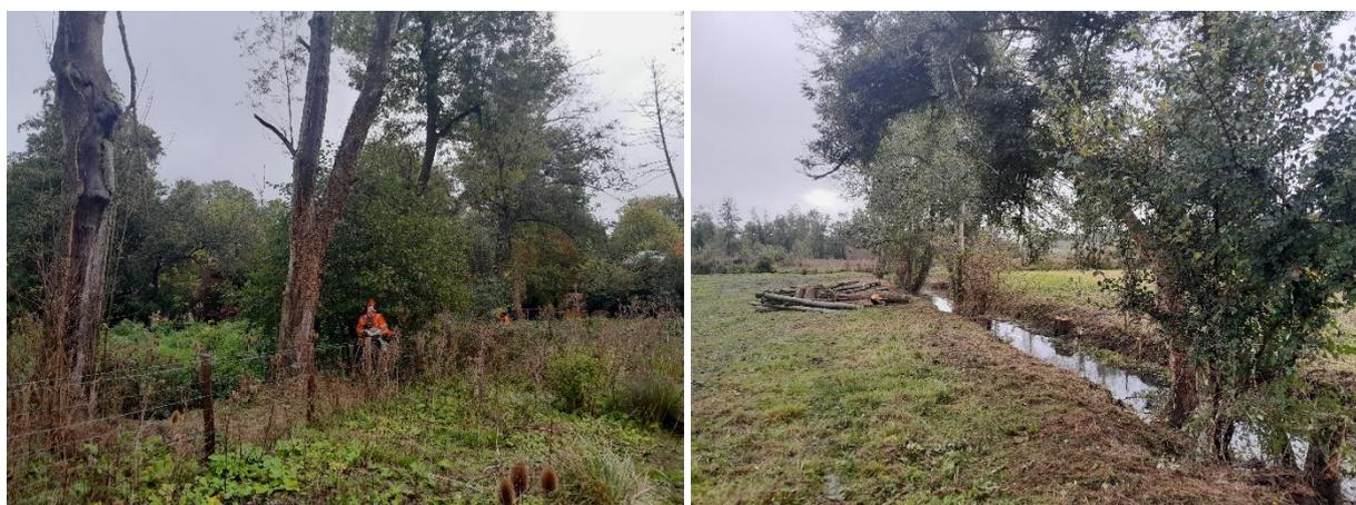
Pour rappel, les travaux de restauration de la continuité écologique du complexe hydraulique du Moulin Garot consistent à renaturer le fossé en fond de vallée et à raser le batardeau en béton à l'amont. L'objectif est de modifier l'attractivité actuelle, dont l'écoulement principal passe par la brèche du bief infranchissable, et de la faire transiter par le fossé réaménagé.
