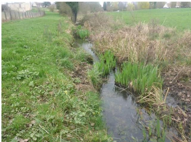
Visite terrain Aquascope - 17/03/2022 : à gauche, installation d'hélophytes sur les banquettes et d'hydrophytes dans le lit ; à droite granulométrie observée de type graviers et cailloux
