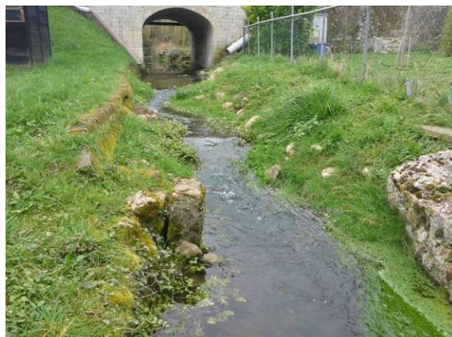
Visite terrain Aquascope - 17/03/2022. A droite, la banquette maçonnée réalisée sous le pont
