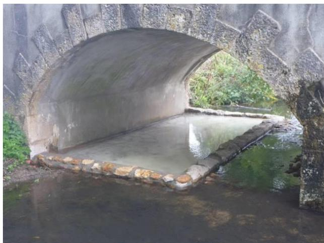
Banquette maçonnée sous le pont après travaux en 2020, vue depuis l'amont
