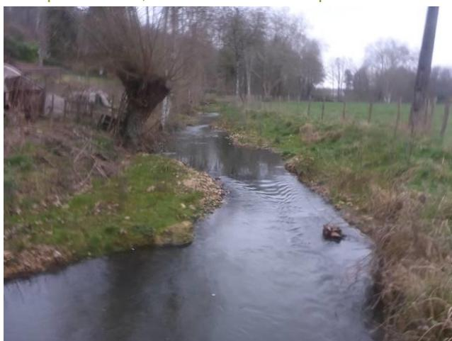
Après travaux en 2022 : à gauche, banquette mal calée par rapport à la ligne d'eau et remaniée par les crues et/ou insuffisamment tassée pendant les travaux. A droite, banquette suffisamment large et stable resserrant le lit d'étiage
