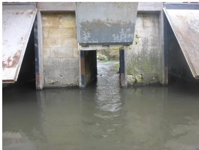
Visite terrain Aquascope - 16/03/2022. Présence du premier radier envoyé à l'aval des arches sur la photographie de gauche permettant de maintenir une certaine ligne d'eau en conditions d'étiage et ainsi assurer une lame d'eau suffisante sous l'arche centrale pour la circulation des poissons
