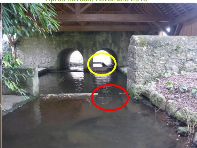
Visite terrain Aquascop - 17/03/2022. A gauche, l'échancrure créée (en rouge) et à droite la vue aval du lavoir après travaux (au premier plan l'échancrure puis au second plan, une banquette maçonnée sous le pont (en jaune))
