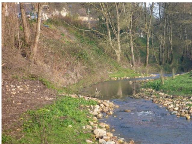
Après travaux en octobre 2017 : resserrement des écoulements et création de radiers
