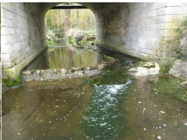
A l'aval des radiers ont été reconstitués pour rehausser la ligne d'eau, stabiliser le profil en long et diversifier les écoulements désormais plus lotiques.
