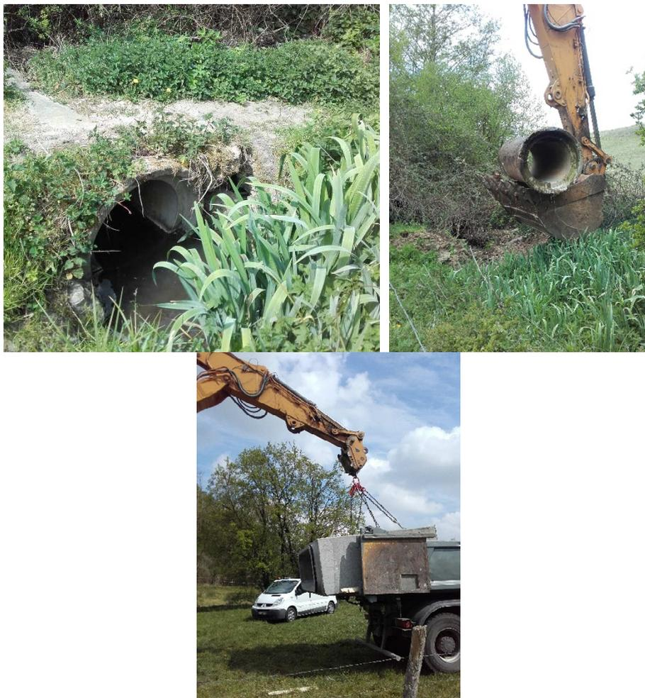
Dépose de l'ancien busage et levage du cadre en béton préfabriqué
