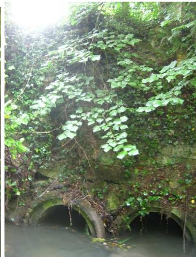
L'ouvrage actuel permet d'accéder à la maison d'habitation située au n°12 bis de la rue du Moulin Million. Il est composé de 2 buses cylindriques juxtaposées de  $\varnothing$  intérieur 800 mm, posées sur le fond de l'ancien bief. La largeur de l'ouvrage est de 2,30 m, la hauteur du parement en parpaing de 2,35 m et la longueur de 9,00 m. L'ensemble de l'ouvrage subit une déstabilisation du fait de la présence d'arbres en périphérie et de l'affaissement d'une buse dans la partie aval.
