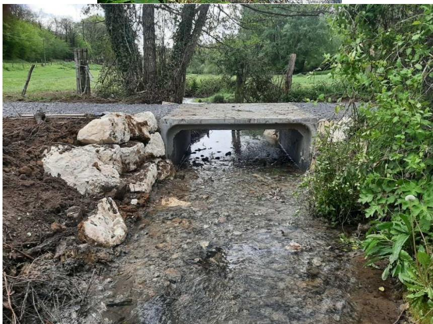
Vue du cadre en place avec les enrochements périphériques et la recharge sous l'ouvrage
