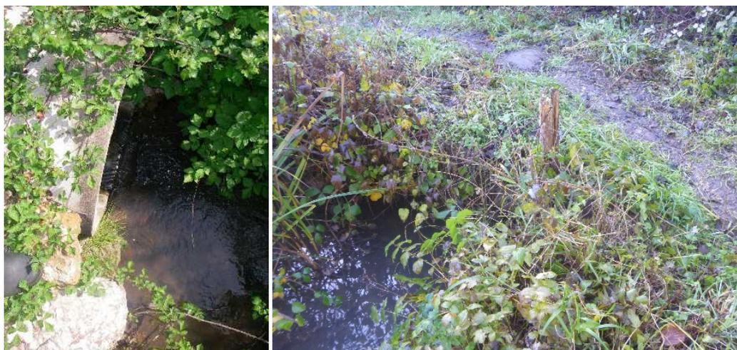
Situé sur la Choisille de Nouzilly, l'ouvrage actuel permet au sentier pédestre de franchir le cours d'eau. Il est composé d'une buse de Ø intérieur 600 mm, posée sur le fond du lit du cours d'eau. La longueur est de 2,00 m avec une largeur de sentier légèrement inférieure. Le propriétaire riverain à l'aval est en limite de l'ouvrage actuel avec un grillage. L'ouvrage est en charge en période de crue.
