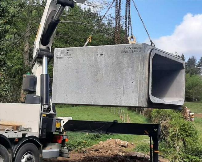
Préparation de l'assise du cadre en béton et opération de levage
