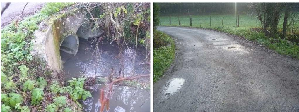
L'ouvrage actuel supporte la route communale de la Sirotière. Il est composé de 2 buses cylindriques juxtaposées de  $\varnothing$  intérieur 600 mm, posées sur le fond du lit du cours d'eau. La largeur de l'ouvrage est de 1,80 m et la longueur de 5,00 m avec une largeur de chaussée d'environ 4,00 m. située dans un virage. L'ouvrage est en charge en période de crue.
