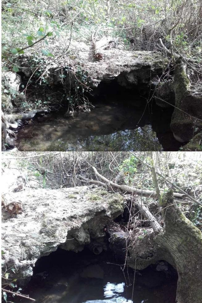
L'ouvrage en béton est situé à l'amont immédiat du passage à gué du Guéret. Il cale la ligne d'eau du Ruisseau de Beauregard (affluent du Ruisseau de Saint Roch) qui s'écoule comme au travers d'un siphon. L'opération consiste à démanteler l'ouvrage et évacuer les matériaux pour rétablir le libre écoulement du ruisseau.
