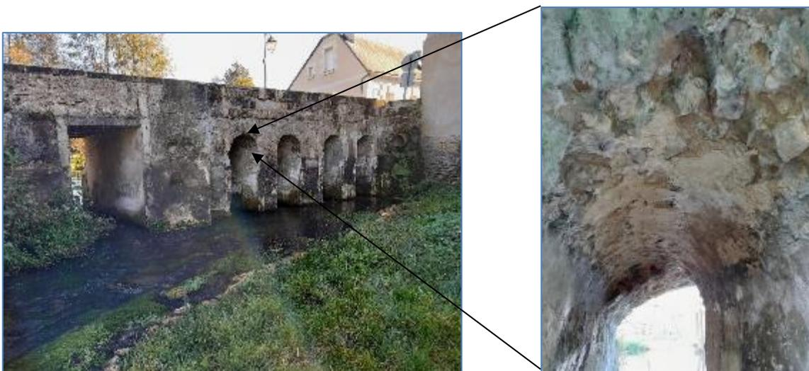
**Figure 27 - Photo du rejointoiement du pont**
